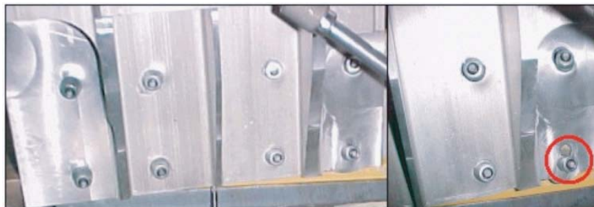
Fig. 7. État de l'assemblage après rupture et démontage.
